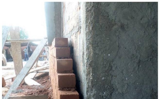
Double enveloppe par des Briques en Terre comprimée stabilisée (confection manuelle)
