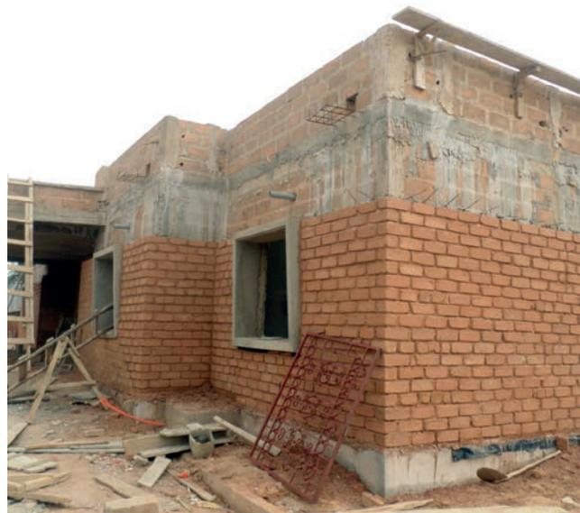
Mur de parement en BTCS en construction
